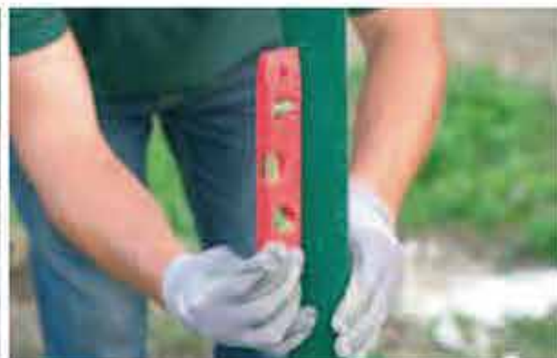
Den Zaunpfahl so aufstellen, dass die Befestigungsnut zur Aussenseite des Grundstückes zeigt und an der Richtschnur anliegt. Zaunpfahl in die Waage richten.
