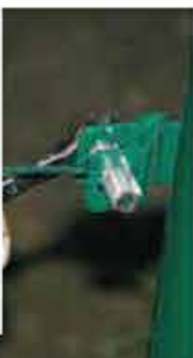
Den Zaunpfahl so aufstellen, dass die Befestigungsnut zur Aussenseite des Grundstückes zeigt und an der Richtschnur anliegt. Zaunpfahl in die Waage richten.
