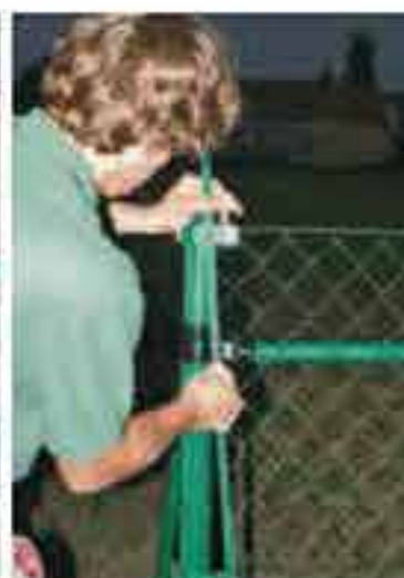
Bei Endpfahl mit der Geflechtsmontage beginnen. Mit Hilfe der Geflechtsleiste wird das Geflecht gespannt und an der Spannsäule fixiert.
