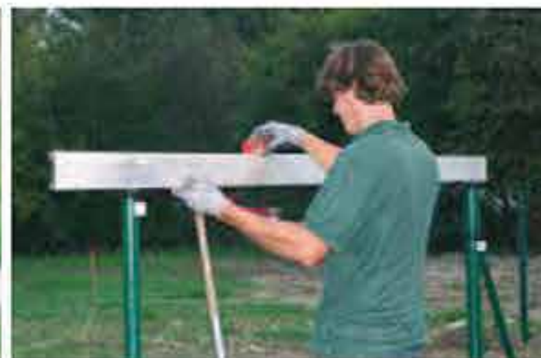
Den Zaunpfahl so aufstellen, dass die Befestigungsnut zur Aussenseite des Grundstückes zeigt und an der Richtschnur anliegt. Zaunpfahl in die Waage richten.
